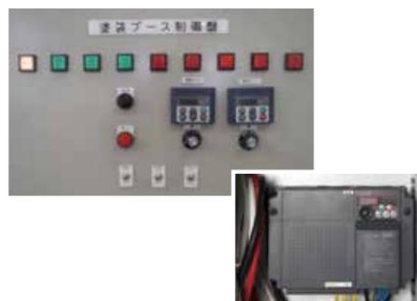
給気・排気ファンモーターをインバーター制御することで、モーターが常に最適な回転数で運転します。標準制御と比較し、無用な運転をおこなわない為ランニングコストの削減につながり、約 15% の省エネ効果があります。
